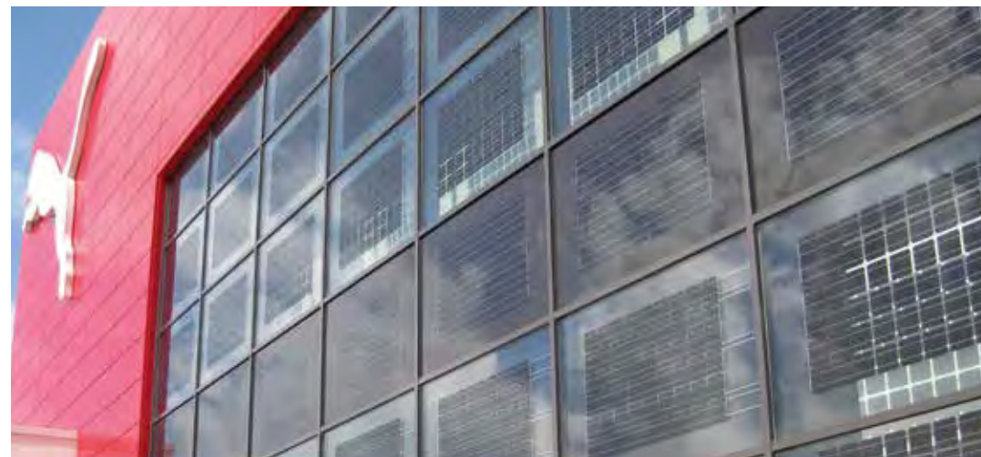
Solartankstelle und Fotovoltaik-Anlage an PUMAs Unternehmenszentrale in Herzogenaurach
